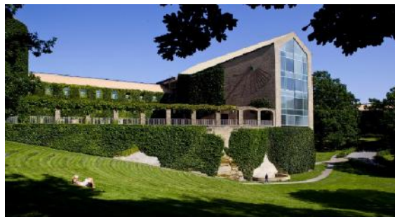
Рис. 3. Вид на головну будівлю
