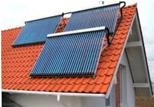
Рис. 1. Загальний вигляд встановлення плоского сонячного колектора в індивідуальній забудові
