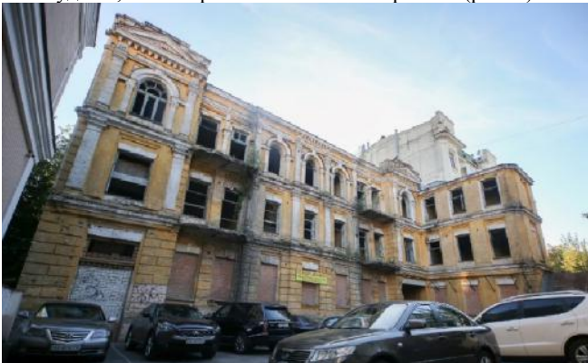
Рис. 1. Флігельна будівля на вул. Ярославів Вал, буд. 15-б
