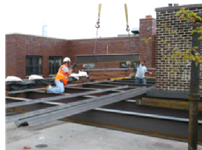
Рис. 1. Монтування сталевого каркасу "Umbrella House" (джерело: http://www.umbrellahouse.nyc/ )
