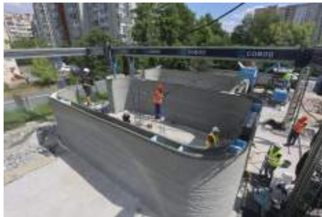
Рис.1. Процес будівництва споруди з використанням 3D-друку.
