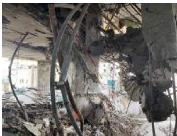
Рисунок 1 – Загальний вигляд зруйнованих пілонів та пошкодженої плити перекриття пілону та руйнування плити перекриття наведена на рисунку 1
