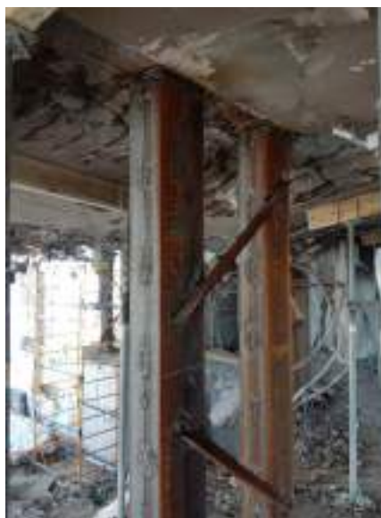
Рисунок 1 – Загальний вигляд влаштованих металевих опор
