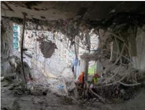
Рисунок 1 – Загальний вигляд зруйнованих пілонів та пошкодженої плити перекриття пілону та руйнування плити перекриття наведена на рисунку 1
