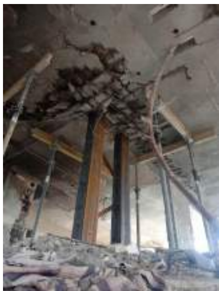
Рисунок 1 – Загальний вигляд влаштованих металевих опор
