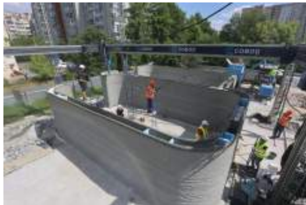
Рис.1. Процес будівництва споруди з використанням 3D-друку.
