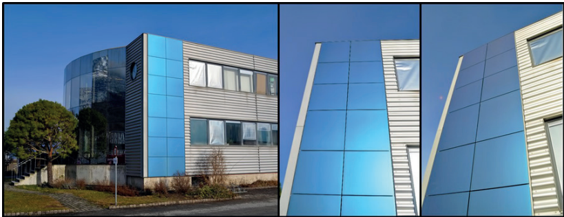
Рис. 1. Фотоелектричні облицювальні панелі на фасадах будівель
