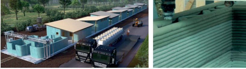
Рис. 1. Будинки економ-класу, що надруковані будівельним 3D-прінтером Vulcan II [1]
