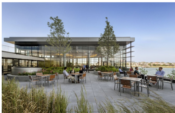
Рис. 1 Реабілітаційний центр у м. Бостон, США. Архітектори: Perkins&Will
